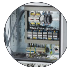
Elektrisk panel med IP-beskyttelse (IP44)
