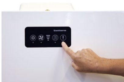
NULSTILLING AF FILTERTIMER
