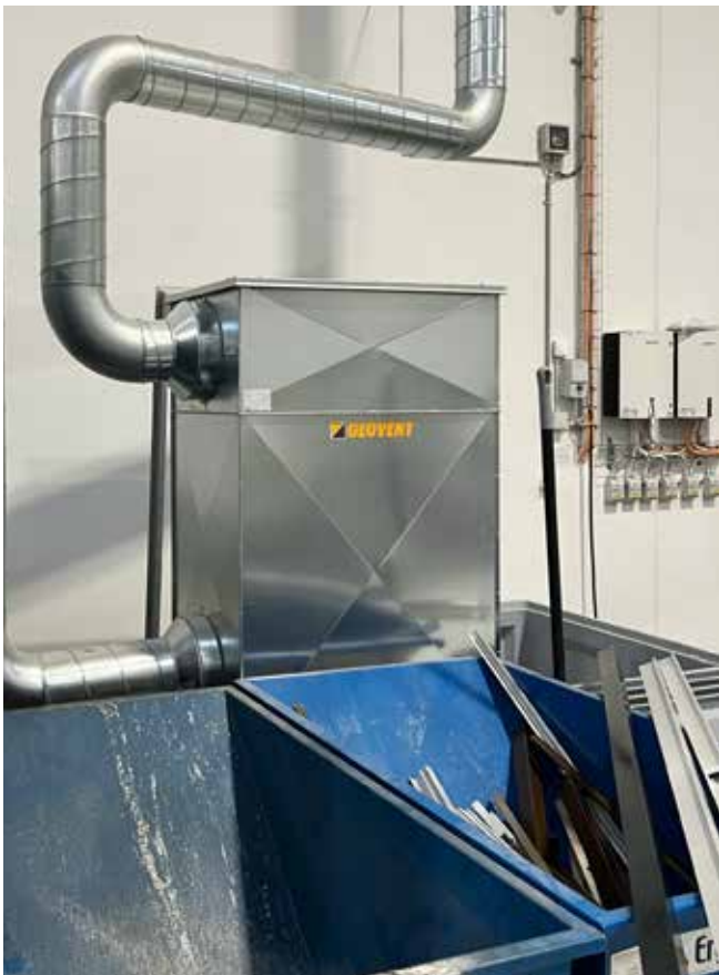
Filtret øverst er en Geovint GF4-filterenhed.
