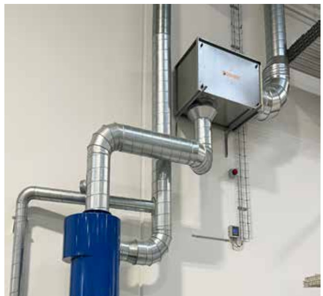
Filtret øverst er en Geovint GF4-filterenhed.
