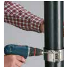
Elektrisk- eller tryckluftsskruvdragare kan användas.
