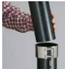
Skjut in den andra rörändan i gummi-manschetten.
