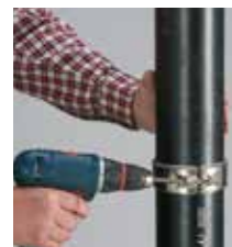
Dra ihop med skruvdragare alt. spärrnyckel (6 mm insex).
