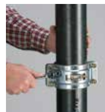
Växeldra de två bultarna med exempelvis en spärrnyckel. Åtdragningsmoment min 20 Nm.
