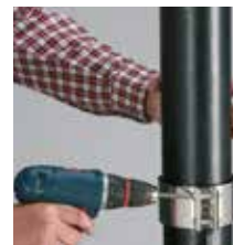
Elektrisk- eller tryckluftsskruvdragare kan användas.
