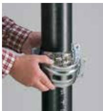
Växeldra de två bultarna med exempelvis en spärrnyckel. Åtdragningsmoment min 20 Nm.
