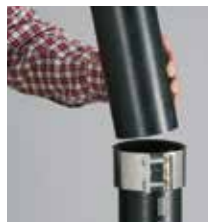
Skjut in den andra rörändan i gummi-manschetten.
