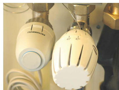
Telestaten tilsluttes styreenheden.
