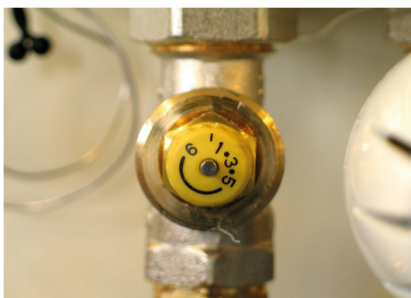
Indregulering foretages på forindstillingsskruen.
