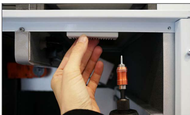
5. Montér CO 2 sensoren i toplåget med selvborende skruer (medfølger i CO 2 sensor kit).
