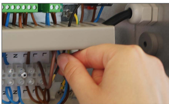
5. Tilslut ledninger som anvist på el-diagrammet.
