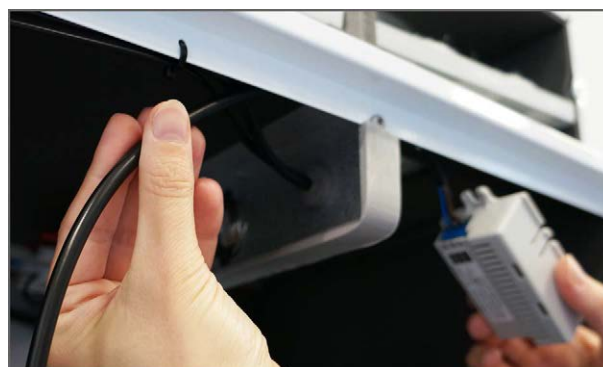
4. Før ledningen fra CO 2 sensoren gennem dette hulrum.
