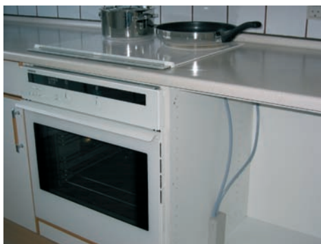
Panelunderlag med udtag for kogeplade og ovn.
