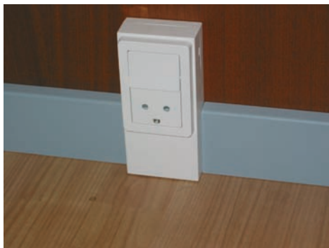
Panelunderlag for stikkontakt e.v.t. afbryder.
