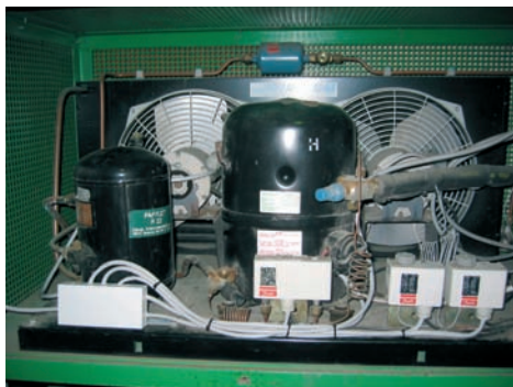
Maskin-unit, 1 tilgang 5 udtag - alle med aflastning, samling i 12 polet klemrække.
