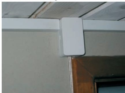
Mini-kabelkanal
