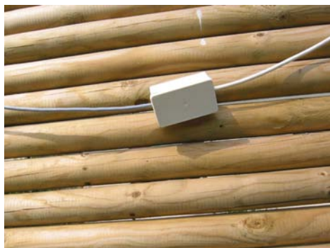
Samling af ledninger med/aflastning
