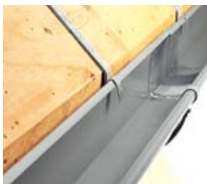
Færdig monteret tagrende med ekspansion.
