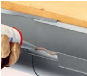
Limstriben til løs vulst påføres.
