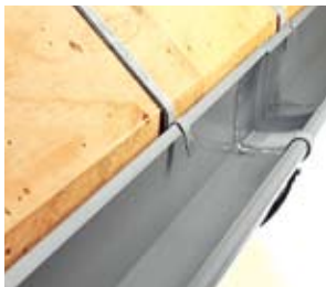
Færdig monteret tagrende med ekspansion.
