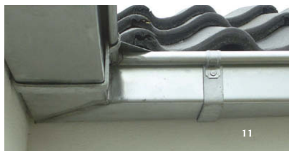
INDVENDIG GERING m/ RENDEJERN. Firkantet. ▶
