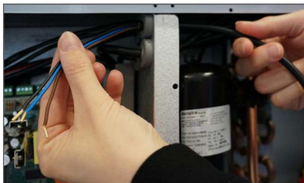
6. Før ledningen fra CO 2 sensoren gennem kabelgennemføringen til automatikken. Tilslut herefter ledning til strømforsyningsboksen.
