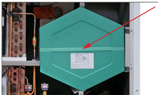
2. Afmonter modstrømsveksleren ved at trække i stroppen (må ikke klippes over).
