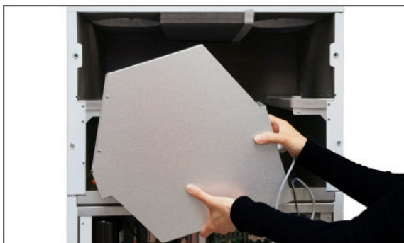
9. Bypass-kassen trækkes ud. Herefter skal 8-pol stikket skubbes ned i kanal til ventilatordel.
