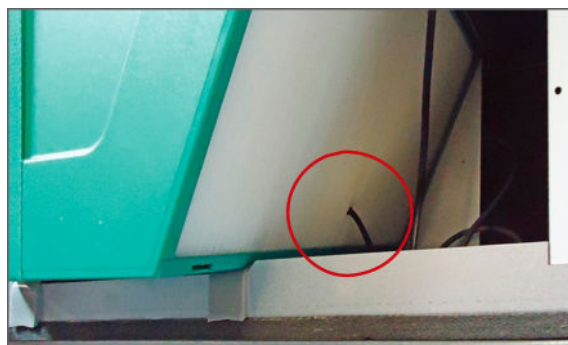
4. T4 føler trækkes ud af modstrømsveksler.
