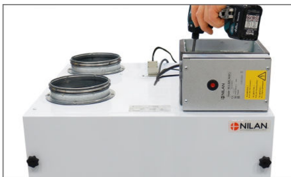
3. Forvarmebladen monteres ved udeluft kanaltilslutningen på toppen (standard) eller på siden af aggregatet (i så fald skal afdækningsplade flyttes for at dække hul i toppen).
