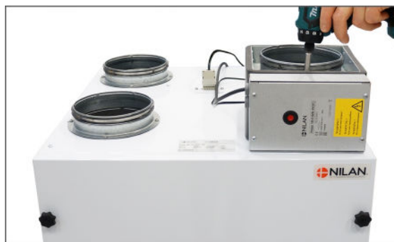
4. Studsen monteres på varmebladen, klar til kanalmontage.
