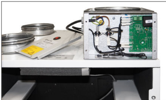
7. Strømforsyningskablet er formonteret i aggregatet og forvarmebladen tilsluttet med Fase (F), Nul (N) og Jord (J).
