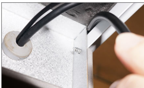
3. Prik hul i skummet over bjælken (hvorunder krydsveksleren har sin placering) for at få adgang til hulrummet i toplåget.
