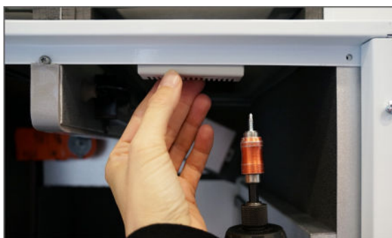
5. Monter CO 2 føleren i toplåget med selvborende skruer (medfølger CO 2 føler kit).
