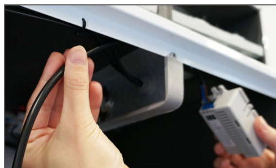
4. Før ledningen fra CO 2 føleren gennem dette hulrum.
