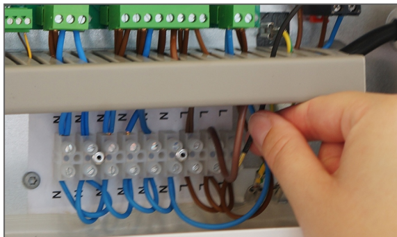
5. Tilslut ledninger som anvist på el-diagrammet.
